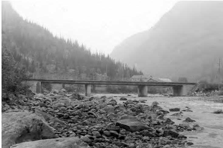
1) foto Grungebru 1963 , Tallaksen, foto Statens vegvesen
