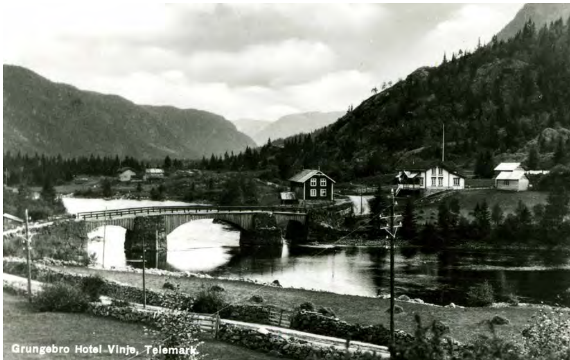
7) Brua frå 1840 sett frå Gunnulfstveit mot Bruspåren
